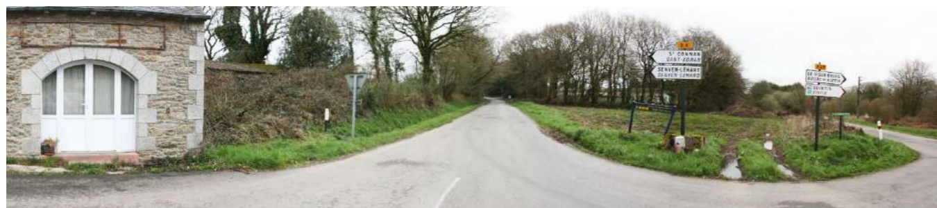
Photo 70 : Maison du hameau du Grand Quélen au croisement de la RD 4 et RD 28, vue en direction de la Zone d'Implantation Potentielle
