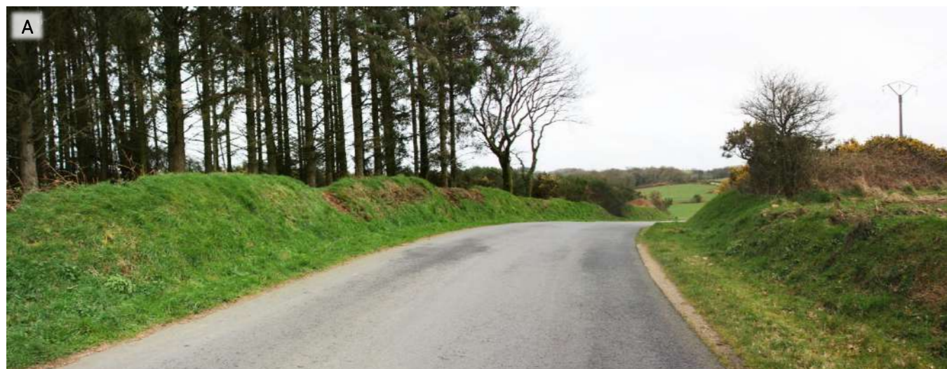
Photo 93 : Point haut au niveau de la RD 4 de la partie 1 de la Zone d'Implantation Potentielle
