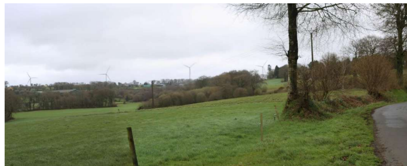
Photo 34 : Les éoliennes du parc éolien du Haut Corlay s'insèrent dans les paysages vallonnés et bocagés du massif du Mené
